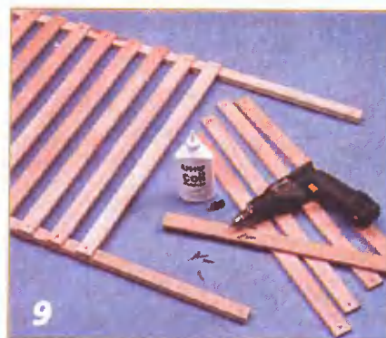
Решётку под матрас 140x70 см собирают из двух брусков 12 и планок 13 на клею и шурупах.
