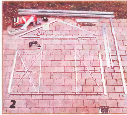
На ровном участке земли раскладывают элементы передней стенки теплицы.
