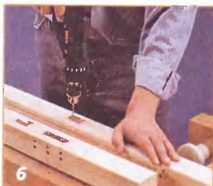
Крепление к стойкам деталей навески ограждения и досок нижней обвязки.
