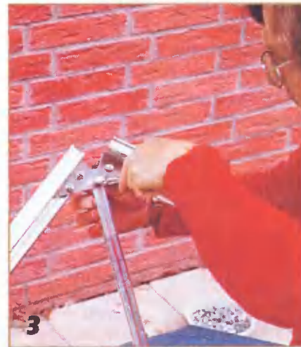
Соединяют торцевой элемент с раскосами и средней связью для остекления.
